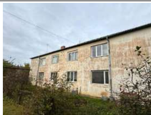
Dzīvojamā māja Liepājas ielā 24
